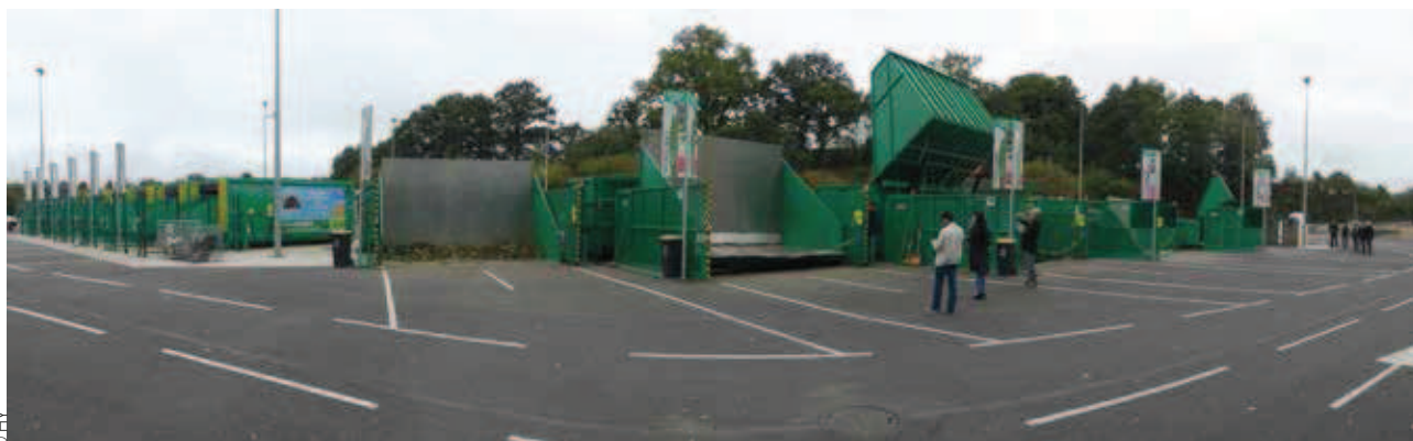
Les trois élévateurs Hulk 2 destinés à la réception des déchets verts desservent des bennes de 30 ou 35 m 3 .
