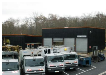
Atelier de Maintenance
