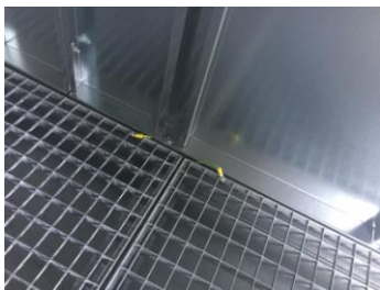
Plancher bac de rétention
