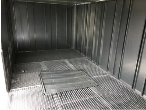
Vue paroi intérieure
