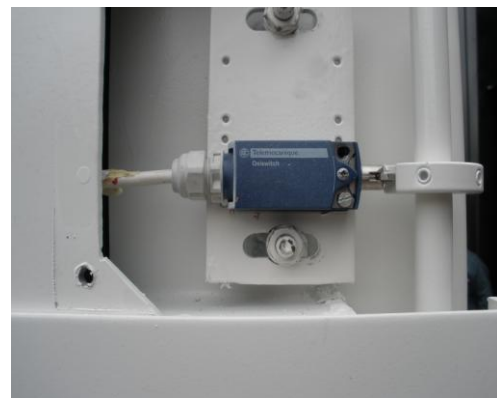
• Contacteur électrique empêchant le fonctionnement du compacteur porte ouvertes
