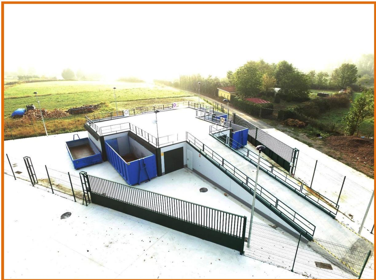
1. LEKO est une déchetterie modulaire béton, elle peut s'adapter aux différentes configuration de terrain
