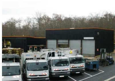
Atelier de Maintenance
