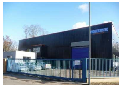
Atelier de Chaudronnerie
