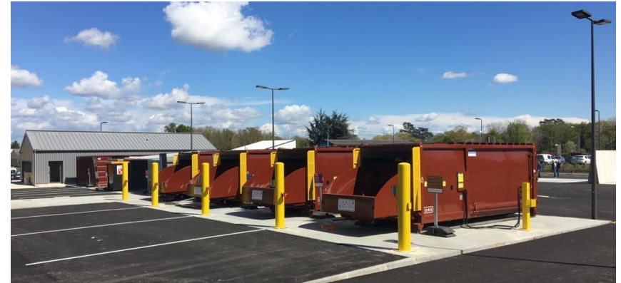
Déchetterie Communautaire Miramont de Guyenne
