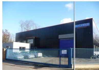
Atelier de Chaudronnerie
