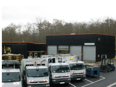
Atelier de Maintenance
