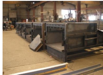
Atelier de Chaudronnerie
