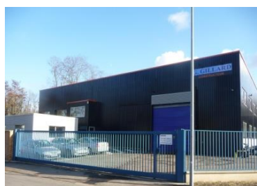
Atelier de Chaudronnerie
