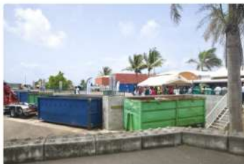
La déchèterie rénovée de Capesterre Belle-Eau respecte désormais toutes les normes de sécurité et d'hygiène. - F. L.
