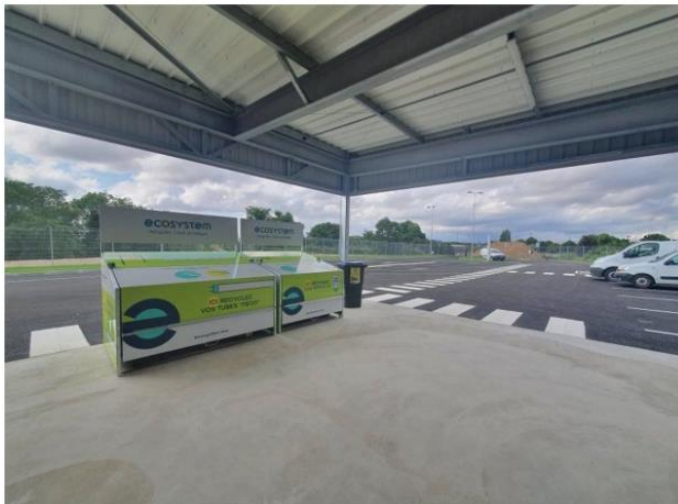
Le préau de la déchèterie nouvelle génération de Provins permet le recyclage d'huile de vidange ou de friture, mais aussi d'ampoules et de cartouches d'encre (©RSM77)
