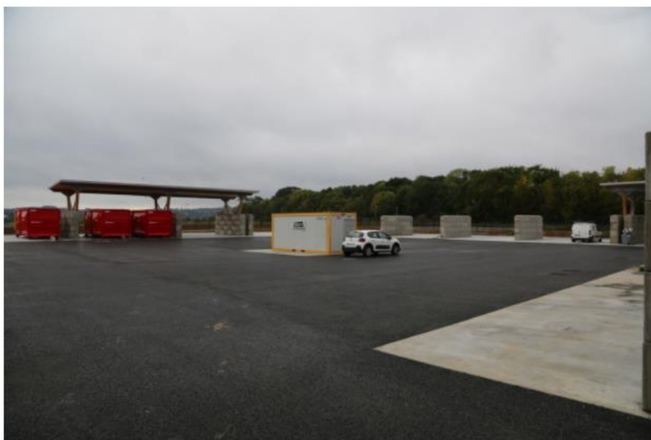
La déchèterie avionnaise est dite « à plat » car elle permet à l'utilisateur de faire moins d'efforts lors du vidage et de le faire en toute sécurité. (©DR)
