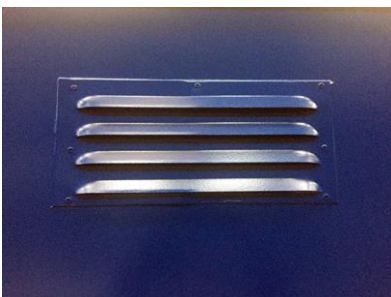
Grille d'aération naturelle
