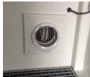
Ventilation ATEX (Vue intérieure et extérieure)
