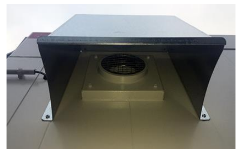
Les clapets coupe-feu d'entrée d'air sont équipés d'une protection
