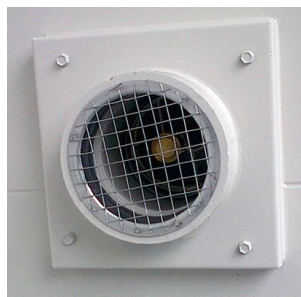
Les clapets coupe-feu d'entrée d'air sont équipés d'une protection
