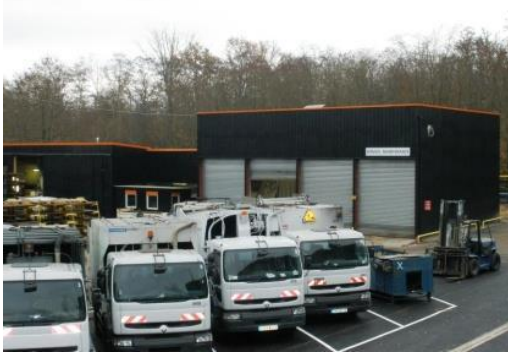
Atelier de Maintenance
