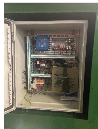
• Armoire électrique incluant une batterie d'alimentation
