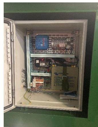
• Armoire électrique incluant une batterie d'alimentation
