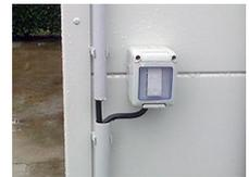
*Pour information* : tous les câblages en zone ATEX doivent impérativement suivre la Norme NF C 15-100: « Des liaisons équipotentielles doivent être réalisées entre les masses et les éléments conducteurs étrangers aux installations électriques et les tubes doivent être en acier ».
