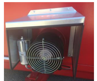
Ventilation ATEX (Vue intérieure et extérieure)
