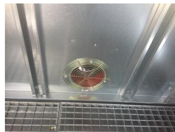
Ventilation ATEX (Vue intérieure et extérieure)
