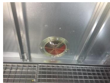
Ventilation ATEX (Vue intérieure et extérieure)
