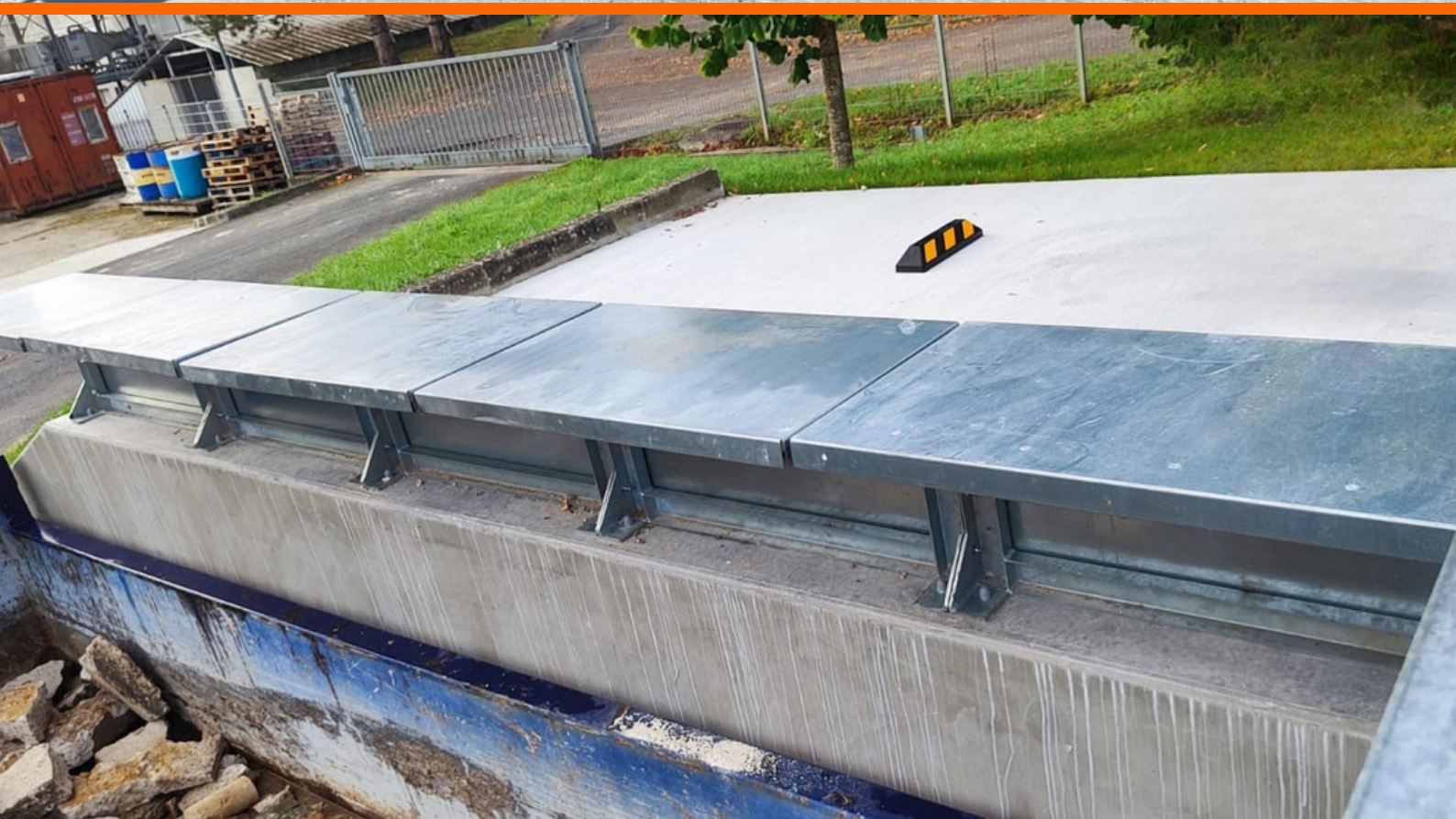
Fixation sur muret béton
