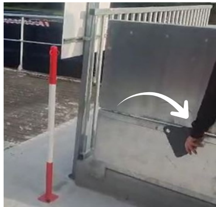
Basculement du plat de verrouillage
