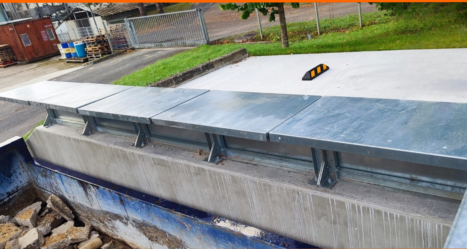
Fixation sur muret béton
