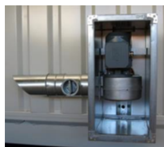
Vue du ventilateur sans le capot, pour mieux présenter le matériel. Tous les ventilateurs sont équipés d'un capot de protection
