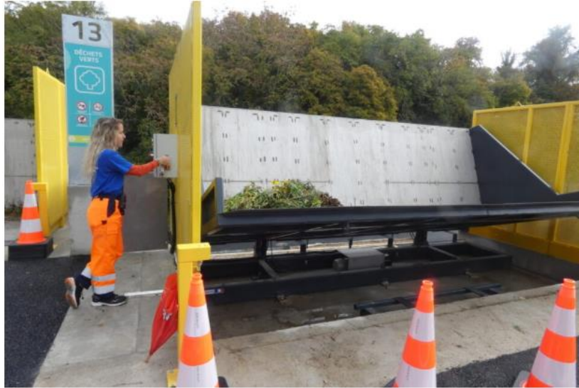
Une fois les déchets verts déposés par les usagers, Maggy actionne le système qui permet de faire basculer les déchets verts dans la benne installée en contrebas. ©Le Démocrate vernonnais
